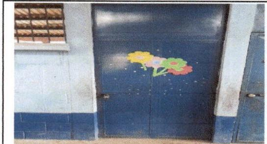
FOTO 3: Mantenimiento a estructura (lijado, cambio de tubo , cepillado, sujeciones, aplicación de pintura) Puertas en aula
